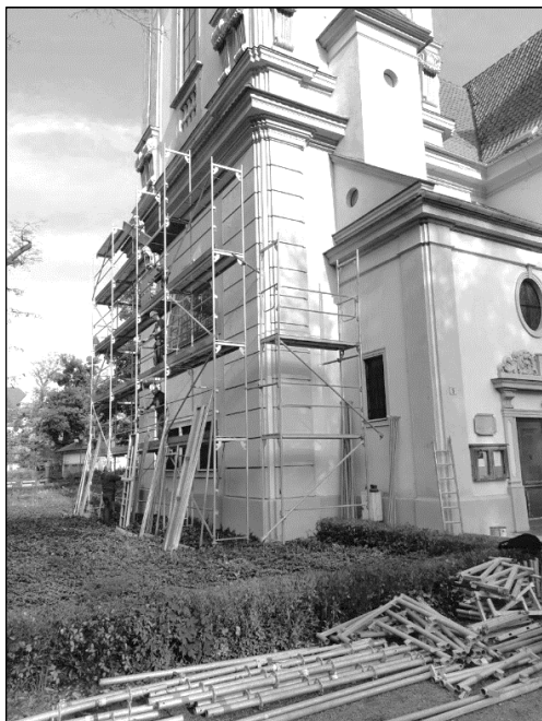
Fot. 8. Remont wieży kościoła
