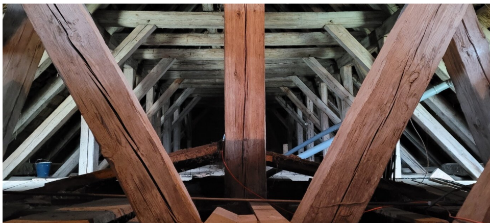
Il. 8: Jasień, kościół pw. Bożego Ciała, widok na więźbę dachową z przestrzeni wieży (fot. N. Wałdoch 2021)
