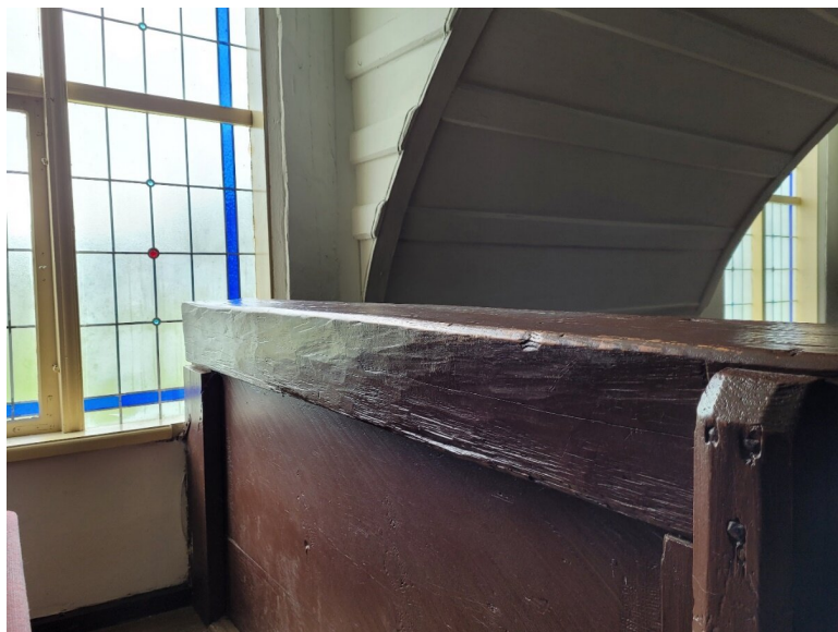
Il. 9: Jasioń, kościół pw. Bożego Ciała, wewnątrz, fragment przedpiersia empory organowej z zachowanymi śladami ręcznej obróbki drewna będących nośnikiem wartości dawności (fot. N. Wałdoch 2022)
