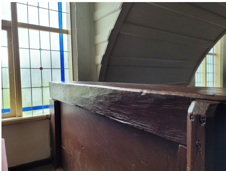
Il. 9: Jasień, kościół pw. Bożego Ciała, wewnątrz, fragment przedpiersia empory organowej z zachowanymi śladami ręcznej obróbki drewna będących nośnikami wartości dawności (fot. N. Wałdoch 2022)
