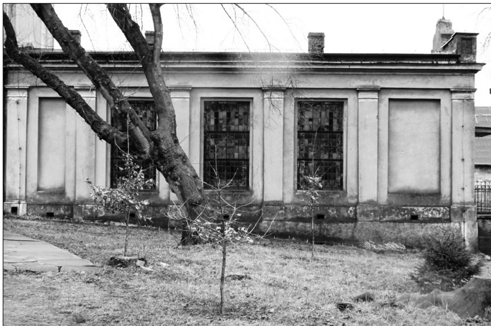
Fot. 7. Widok na kaplicę od strony południowej – 2002 r.
