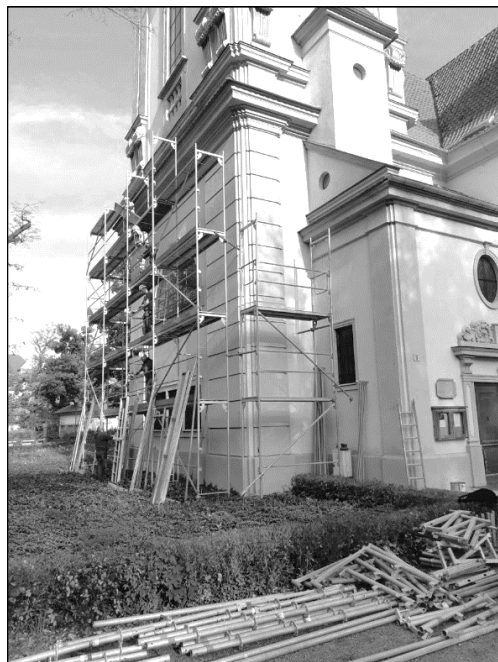
Fot. 8. Remont wieży kościoła
