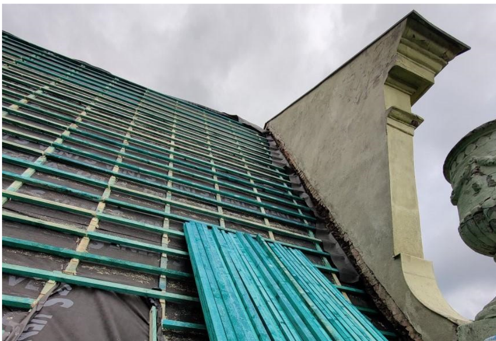
Remont dachu Kościoła Zbawiciela
